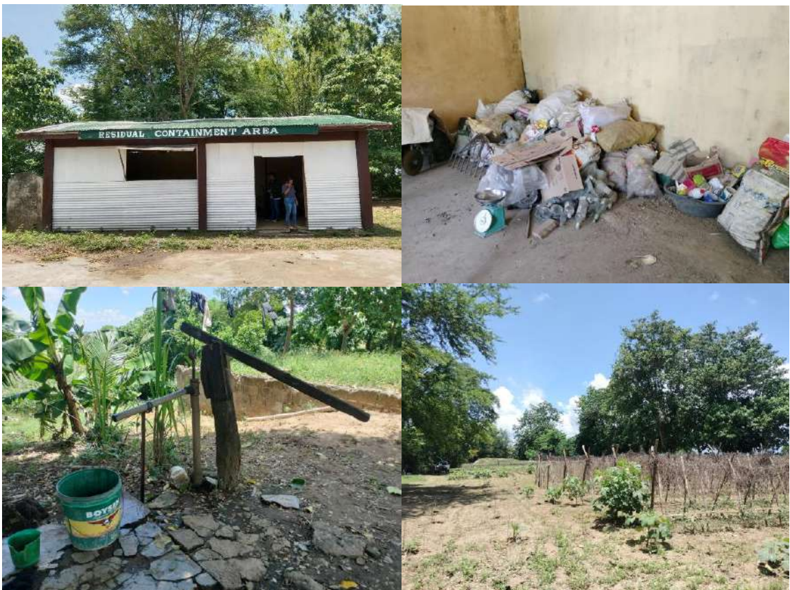
Sto. Tomas RCA at Brgy. Baleleng, Sto. Tomas, Isabela
